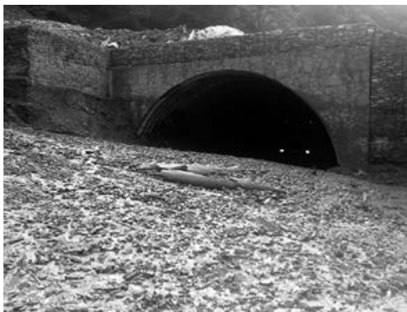
Рис. 4, 5. Заваленный селезащитный тоннель в июне 2014 года и следы грязи на его стенках в мае 2017 года (фото автора)
