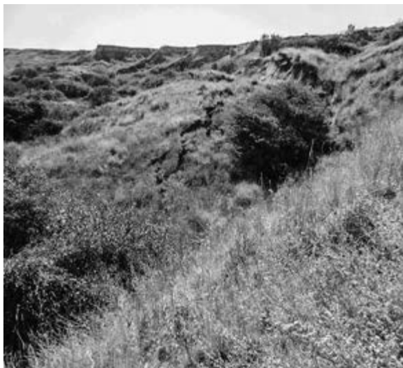
Рис. 4. Сейсмогравитационные процессы на склоне
