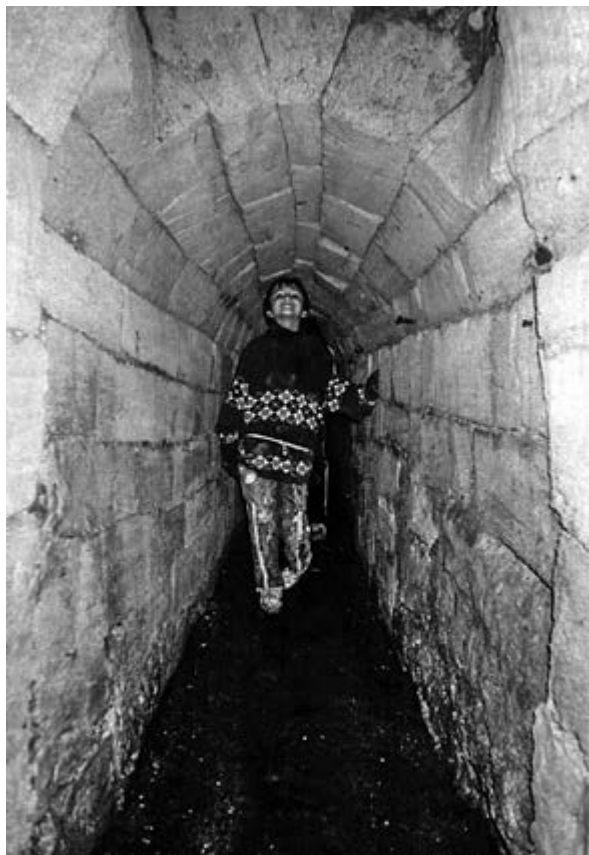
Рис. 11. Коллектор водопровода 1853 г. под Театральной улицей
