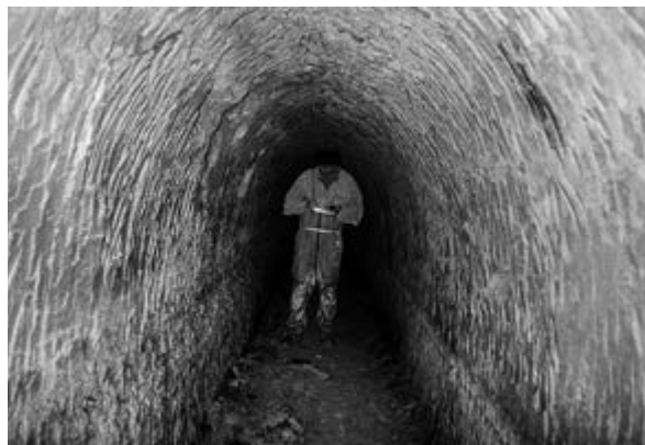
Рис. 7. Дренажная галерея (№ 8), вскрывающая водоносный горизонт
