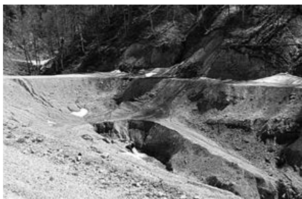
Рис. 4. Автомобильная дорога в верховьях р. Пиехи до схода селевого потока. Фото Д. Ю. Шулякова. Сентябрь 2011 г.
