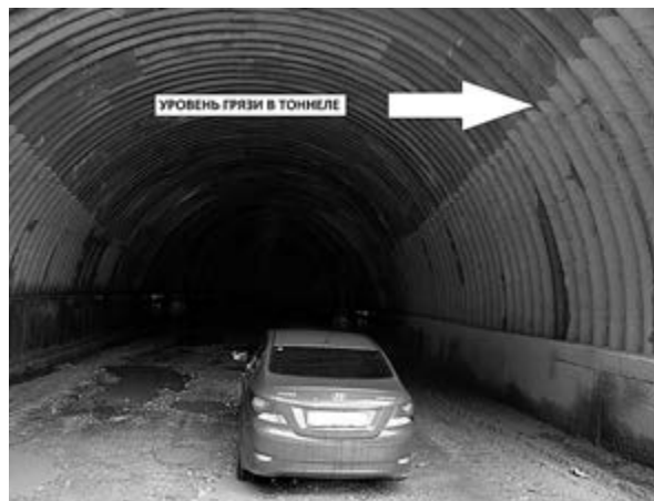
Рис. 4, 5. Заваленный селезащитный тоннель в июне 2014 года и следы грязи на его стенках в мае 2017 года (фото автора)
